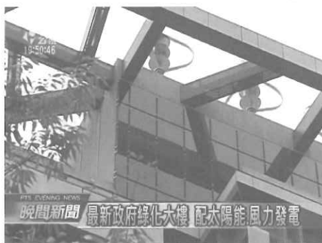
圖11 PNN報導台灣交通部公路總局新大樓屋頂應用
