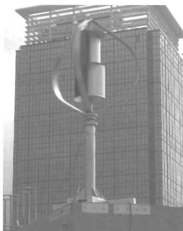
圖8 香港特別行政區政府機電工程署大樓屋頂應用
