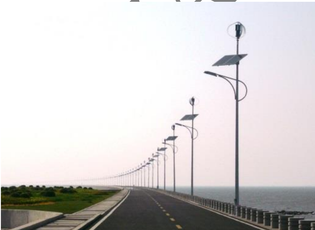
Wind-Solar-Hybridsystem für Straßenbeleuchtung, Shanghai, China
