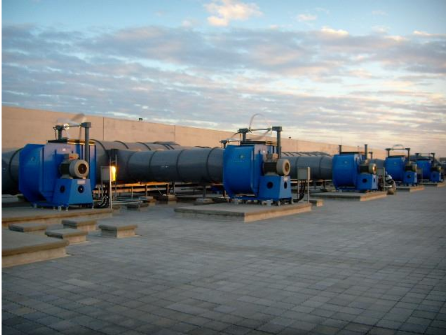
Energierückgewinnungssystem bei AU Optronics, Taichung, Taiwan
