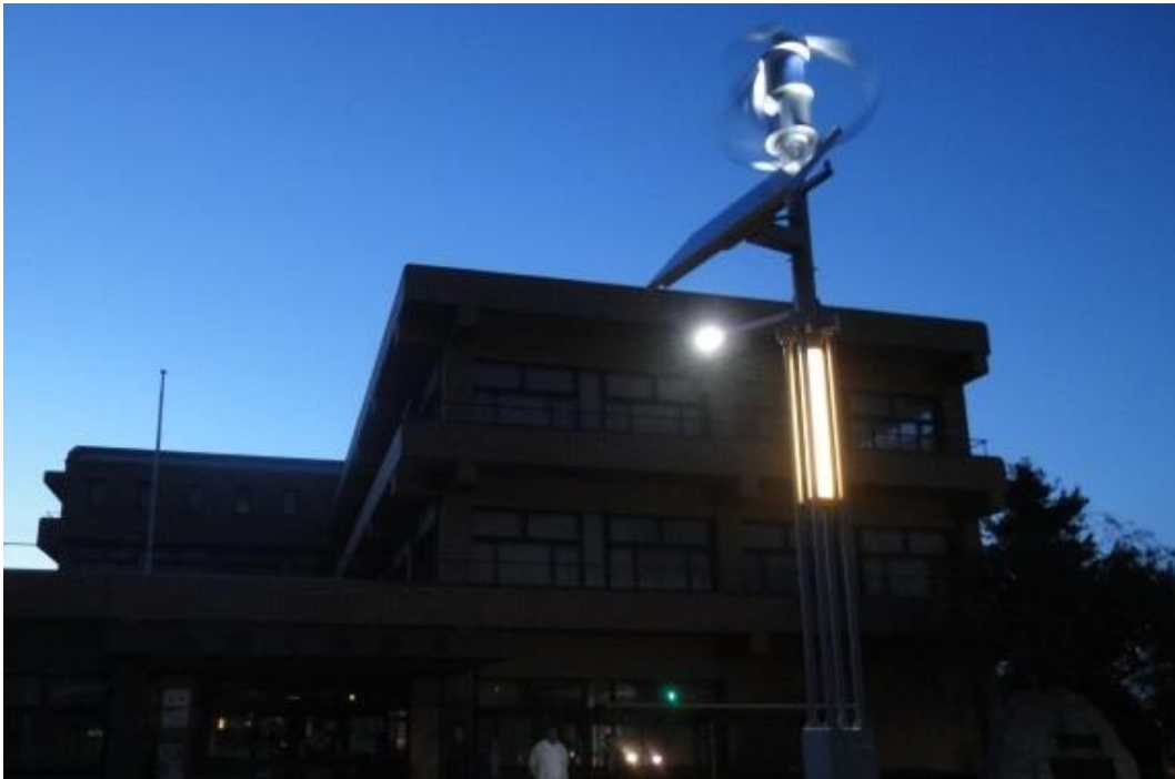
Wind-Solar-Hybridsystem für Parkplatzbeleuchtung, Ibaraki, Japan
