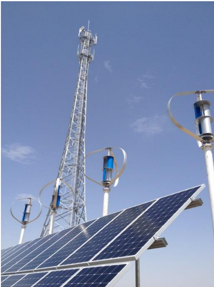
China Mobile Telekommunikationsstation, Xinjiang, China
