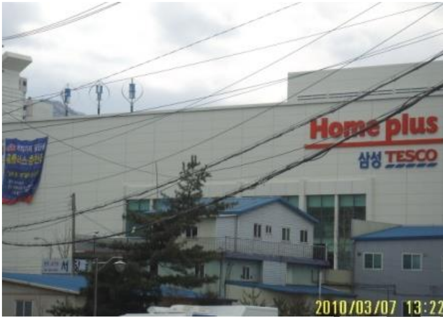
Dachanwendung auf einer TESCO Filiale, Korea
